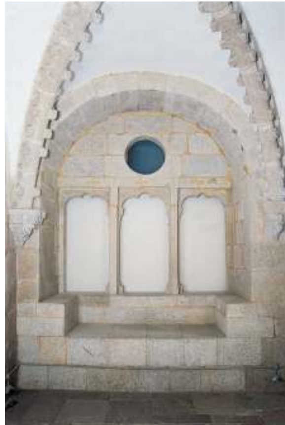
Salón do Pazo de Xelmírez: Fig. 25. Ventá norte. Fig. 26. Lintel no muro occidental. (Arquivo Yzquierdo).
